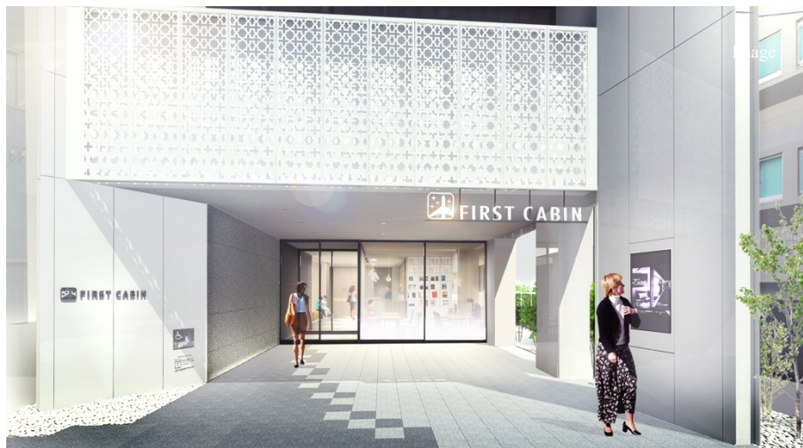
パンチングメタルを用いた柔らかな印象のファサード
